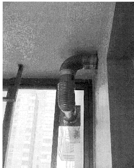
図2. 隣室から延びた排煙管
